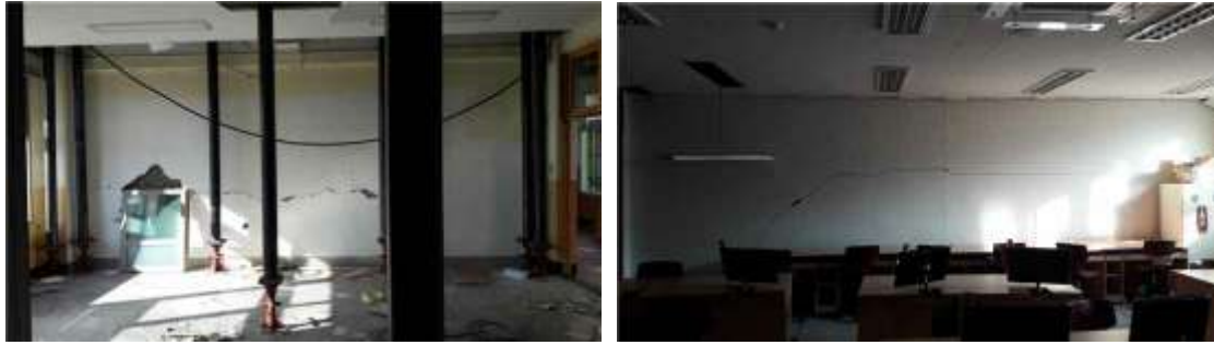
[해그림 6-7] 조적채움벽의 수평줄눈균열 (홍해초등학교, 2017 포항지진)
