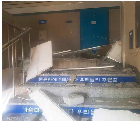
[해그림 17-4] 천장 탈락에 의한 복도 및 계단실 피난경로 피해 사례 (2017. 포항지진)
