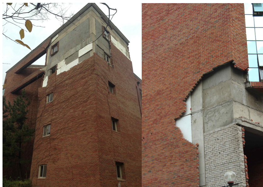
[해그림 17-1] 부착 및 앵커링이 되지 않은 조적 외장재의 지진피해 (2017. 포항지진)
