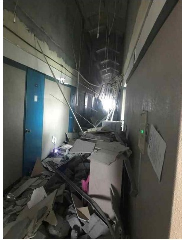
[해그림 17-4] 천장 탈락에 의한 복도 및 계단실 피난경로 피해 사례 (2017. 포항지진)
